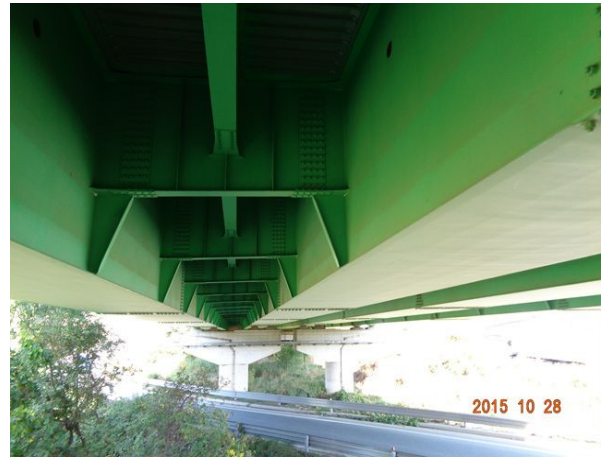
바닥판 및 거더 전경
